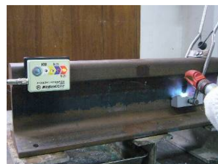
青LED点灯後、作業開始 赤LED点灯後、作業終了
